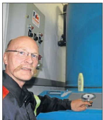
Betriebsleiter Heinrich Voigt stellt Freitag die Heizung an.
